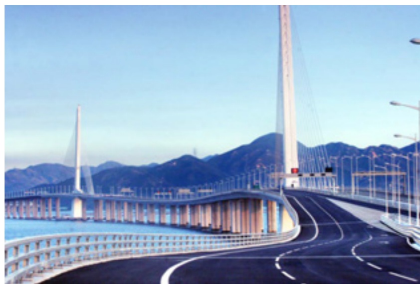
深圳湾跨海大桥公路
