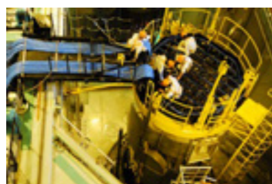
核岛内部检修
