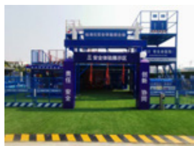
子公司民用项目现场安全体验区
