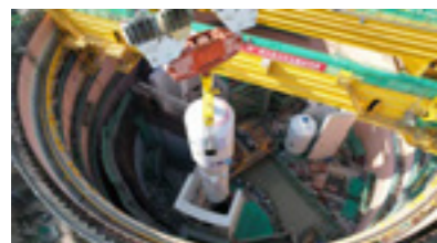
华龙一号蒸汽发生器吊装
