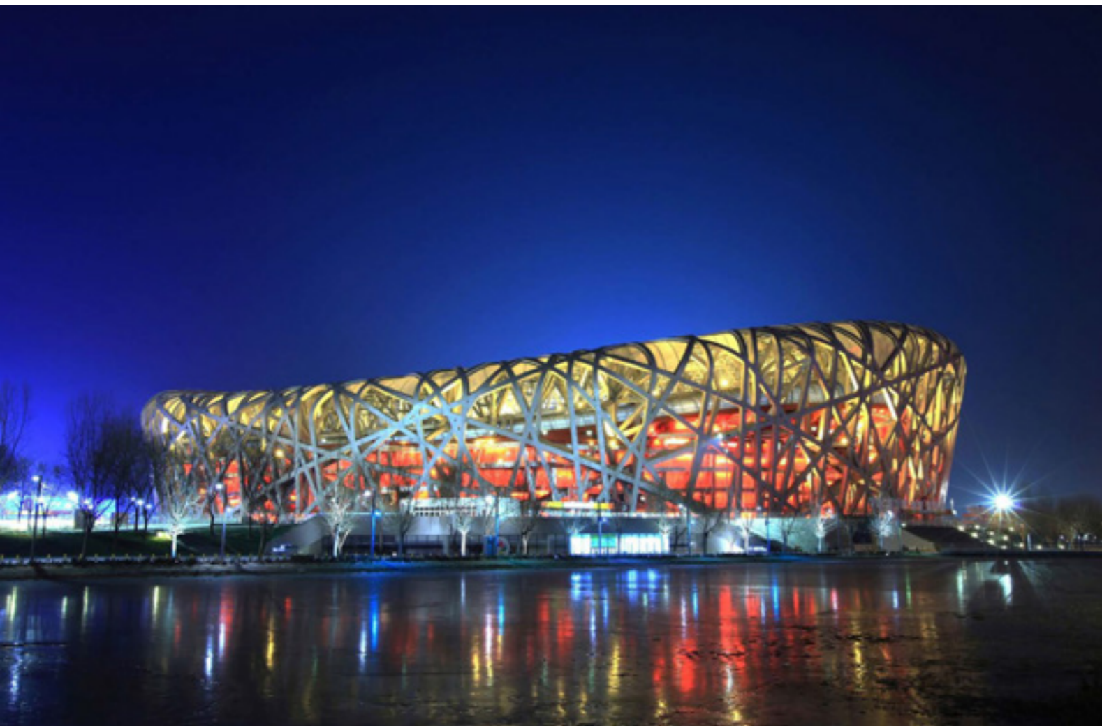
北京奥运主会场国家体育馆（鸟巢）钢结构吊装工程
