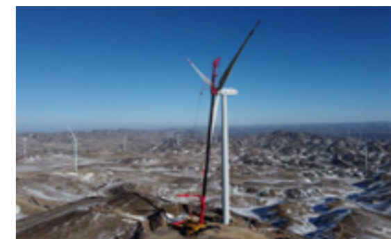
1600 吨汽车式起重机在边疆雪山上开展对接叶轮工作
